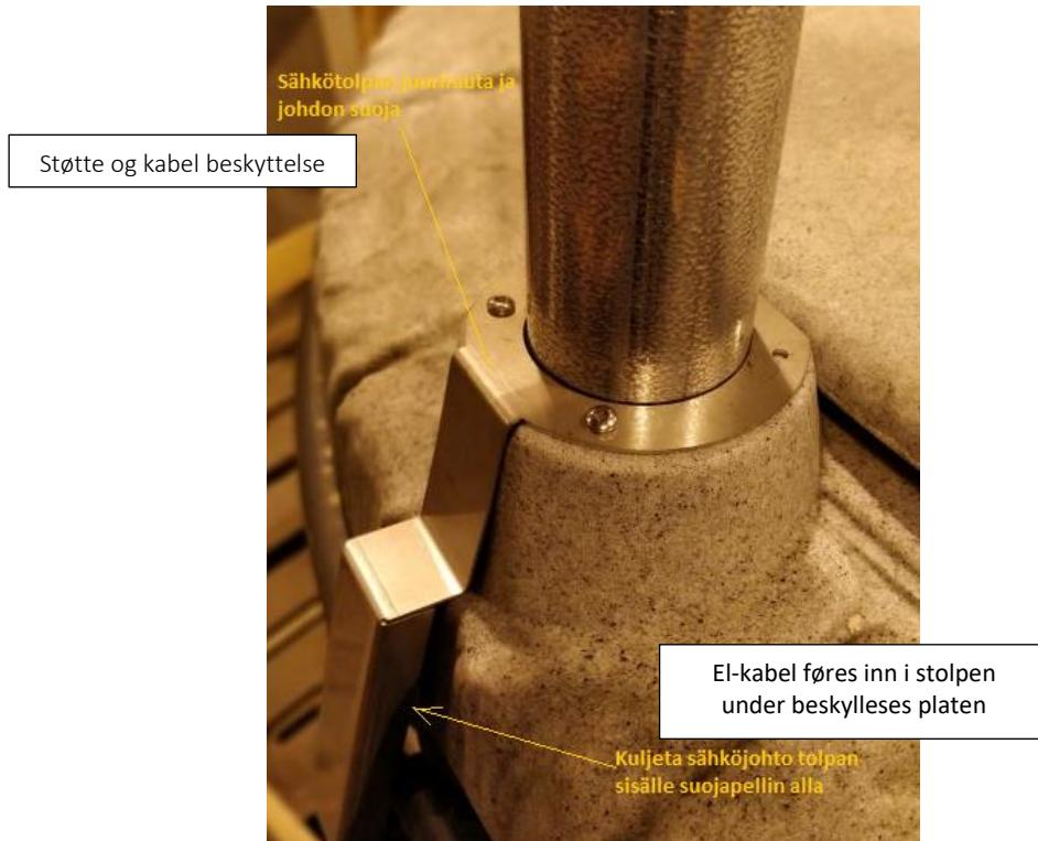
Kablene fra Biostone-enhetens sirkulationspumpe, overføringspumpen og nivågivaren dras inni sentralstolpen till styringenheten og ansluttes direkte till tikoblingene i el-sentralen. El-kablene fra kemikaliepumpen og slamreturpumpen i Chemstone-enheten føres gjennom et D110 mm beskyttelses rør først till Biostone-enheten og videre gjennom styringenhetens stolpe til styringssentralen i locket (se kopplingsskjema).
